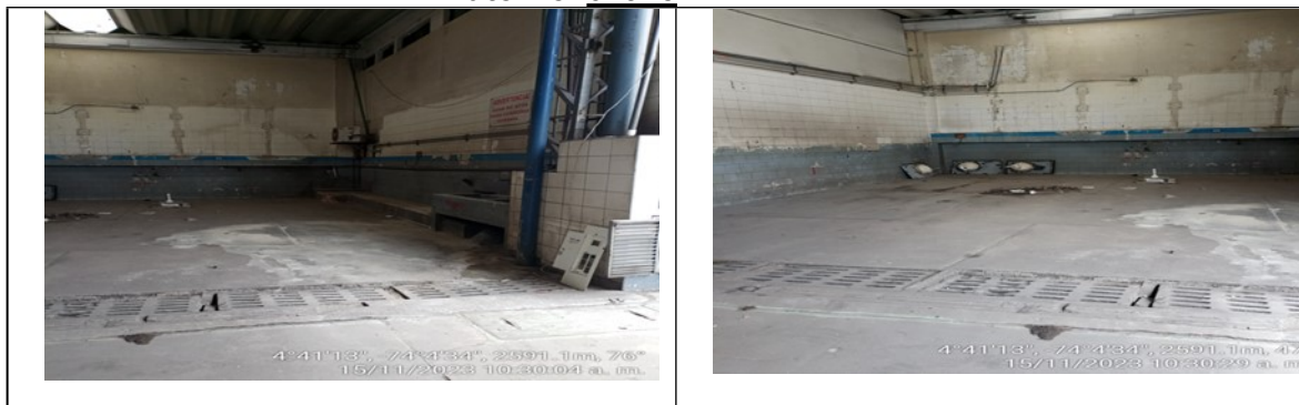
Fotografía 4 y 5. Antigua área de lavadero Taller 1
