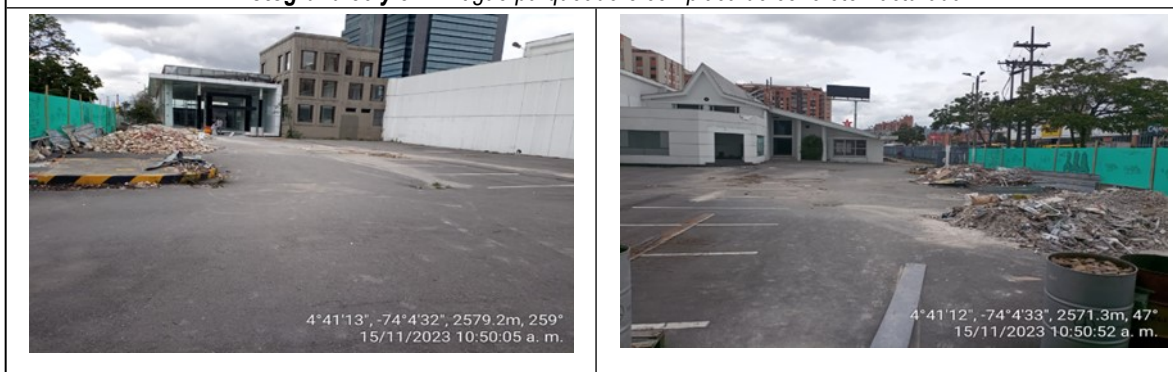
Fotografía 32 y 33. Antiguo parqueadero con placa de concreto en buen estado y localización de escombros resultantes de la expropiación ampliación Av. Carrera 68
